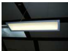
LED照明導入
